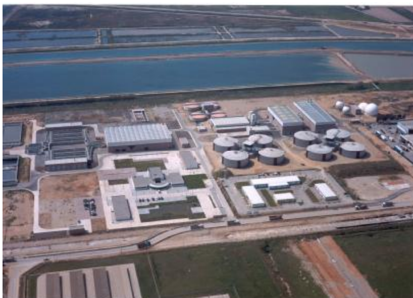
Figura 1. Vista aérea de la EDAR del Baix Llobregat
