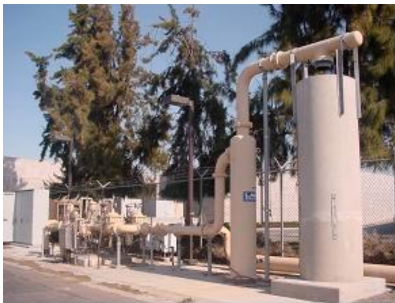
Figura 10. Instalación de pozo de inyección
