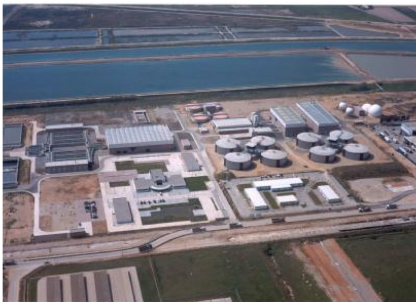
Figura 1. Vista aèria EDAR del Baix Llobregat
