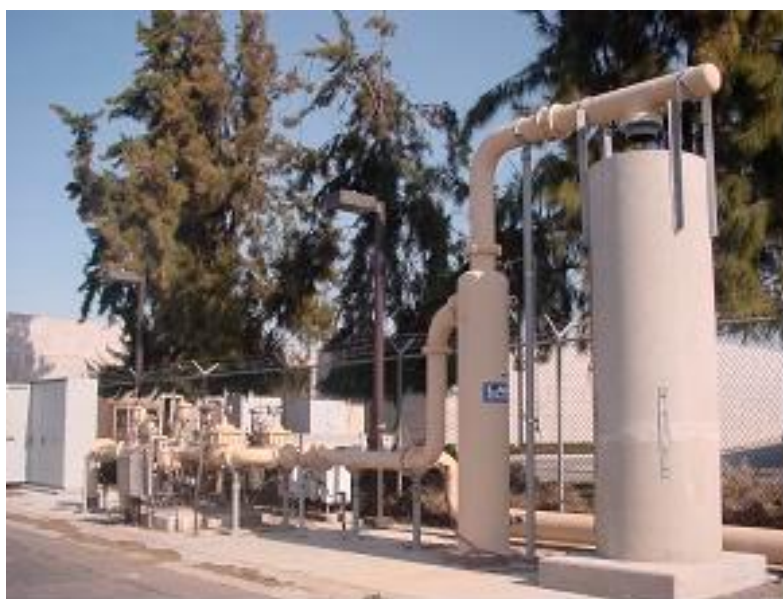
Figura 10. Instal·lació de pou d'injecció
