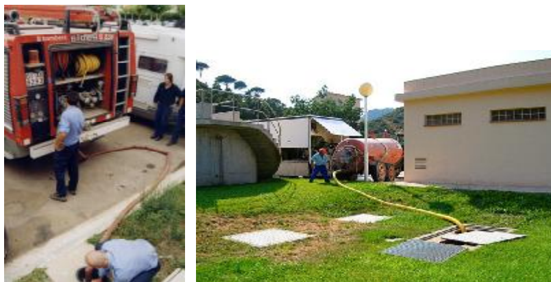
Figura 8. Dos imágenes de usos no potables en municipios de la Costa Brava norte. Izquierda: Bomberos cargando agua regenerada en el hidrante de la EDAR de Port de la Selva, verano de 2003. Derecha: Cuba cargando en el depósito de agua regenerada de la EDAR de Portbou, para su uso en la construcción de la nueva carretera, 30 de junio de 2005.
