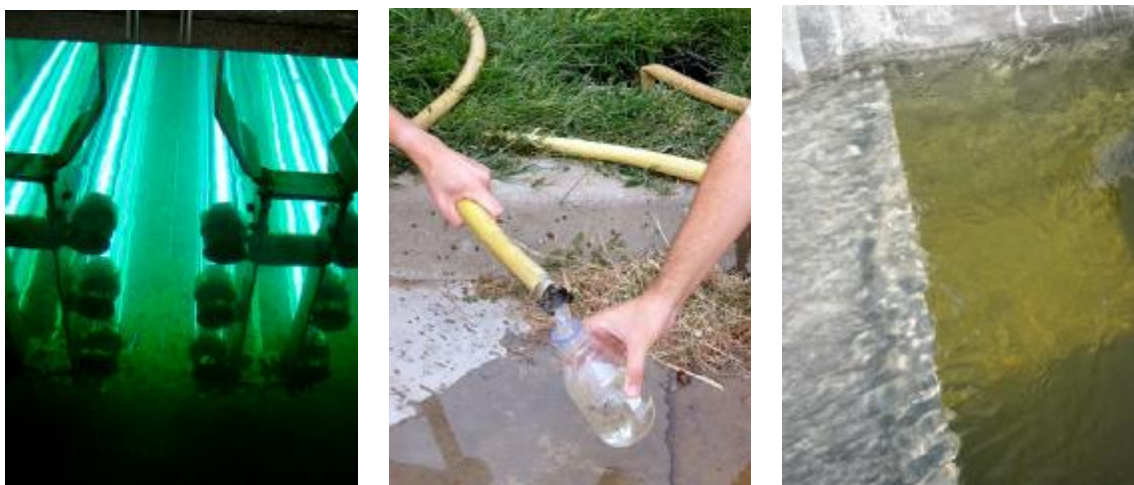
Figura 3. Imatges de diferents aigües regenerades produïdes en la Costa Brava. Esquerra: Equip de desinfecció UV de l'EDAR de Torroella de Montgrí, 22 de juliol de 2005. Centre: Aigua regenerada produïda a l'EDAR de Colera, 17 d'agost de 2005. Dreta: Aigua regenerada produïda per l'EDAR de Blanes, 9 d'agost de 2005.
