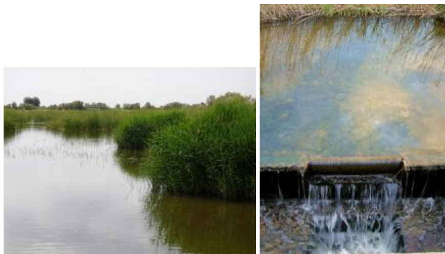
Figuras 2 y 3. Sistema de humedales construidos de Empuriabrava. Izquierda: Vista general de la celda número 1 (19 de mayo de 2006). Derecha: Detalle del aliviadero de salida del sistema (18 de noviembre de 2005).
