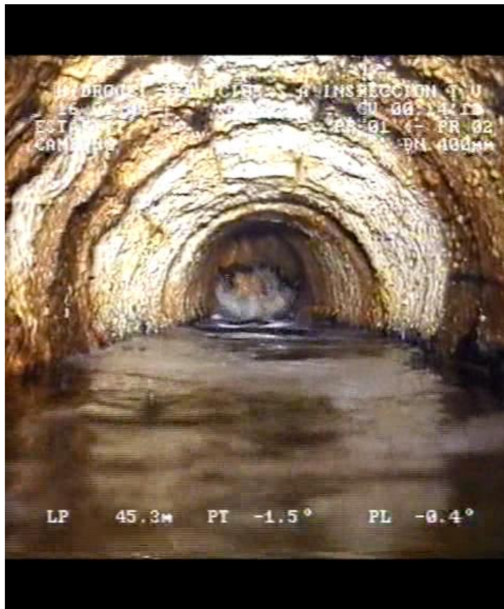
Ebar Central L'Estartit
